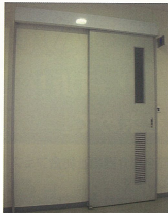
医療機関や介護施設内のトイレのドアなどを自動化することは施設内感染防止のためにも重要
